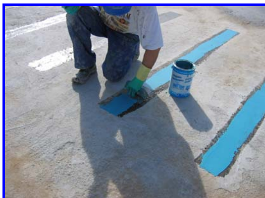
MBrace Resin 220 sobre el hormigón
