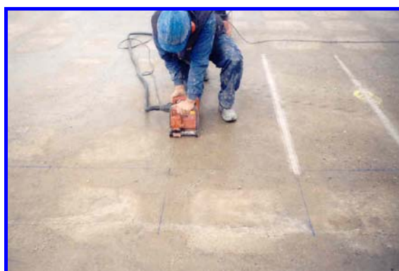
Realización de cortes en el hormigón
