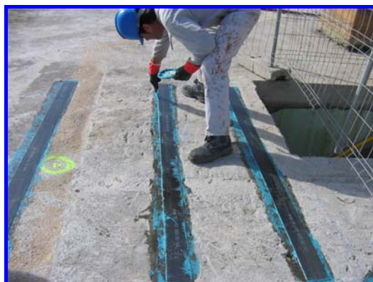
Colocación de laminado MBrace
