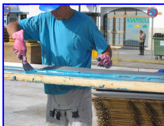
Aplicación de adhesivo en laminado
