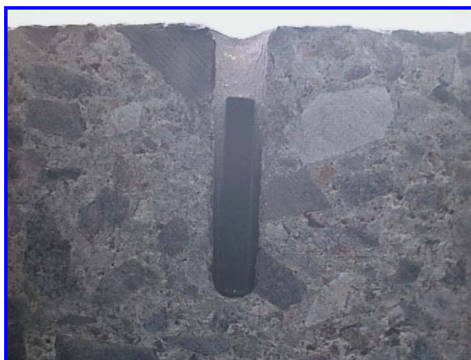
Detalle de laminado embebido en el hormigón. Sistema "cut in"
