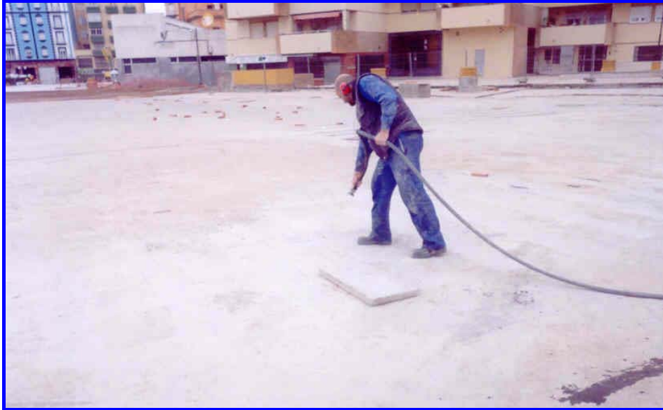
Limpieza del interior de los cortes con aire a presión
