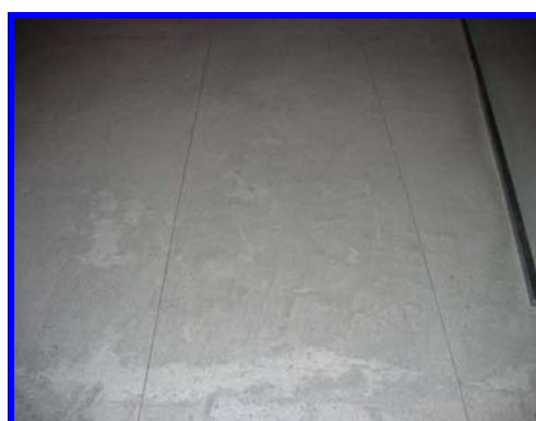
Realización de cortes en el hormigón
