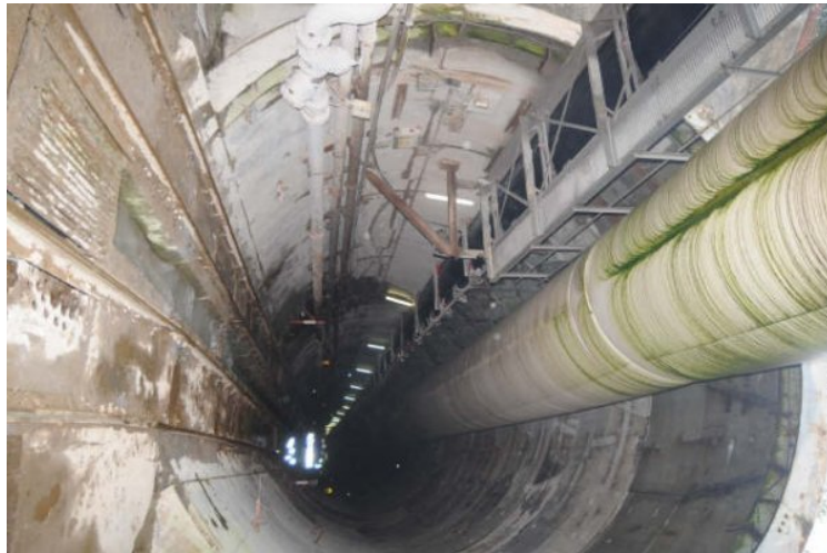
Túneles de Pajares. Boca Norte
