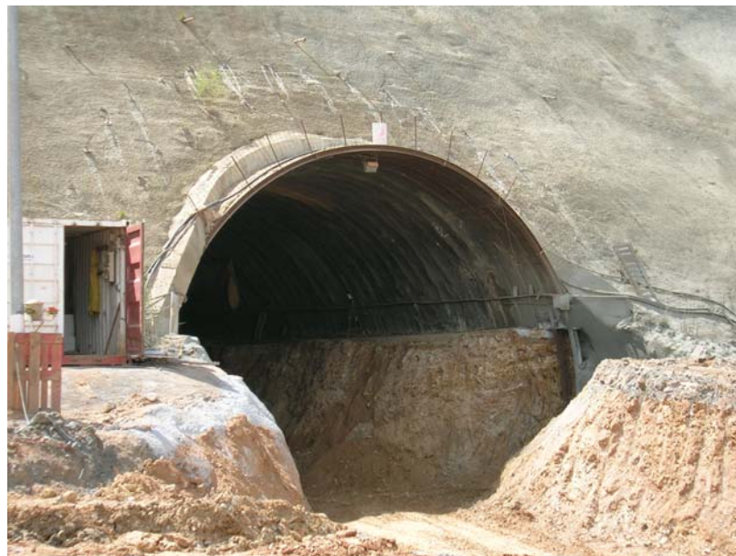
Túneles Autovía A-63 Tr. Grado-Doriga-Cornellana
